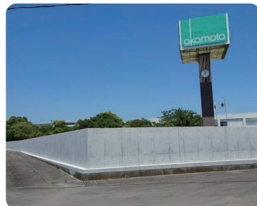
工場全体を囲む防水壁の設置
